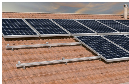
Montáž FV panelů na šikmou střehu
