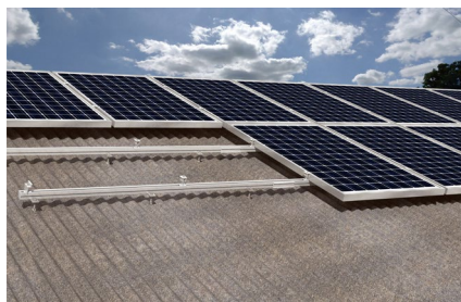
Instalace solárních panelů na šikmé střechy s vlnitou krytinou
