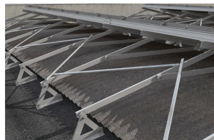
Zavětrování speciálních konstrukcí
