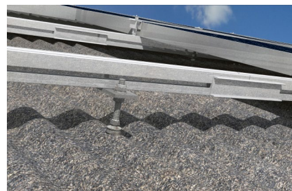
Detail upevnění úchytem SSP
