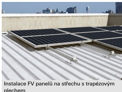
Detail upevnění s kombišroubem STSI
