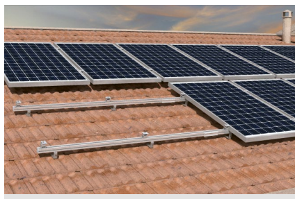
Šikmá střecha s taškovou střechou
