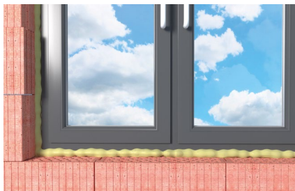
Spáry kolem výplní stavebních otvorů
