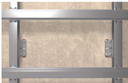
Nosné fasádní konstrukce
