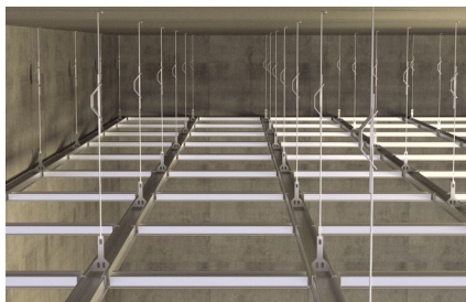
Drátěná táhla zavěšených podhledů
