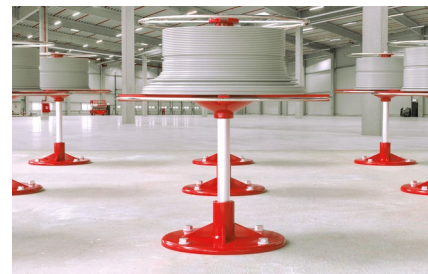
Kotvení ve výrobě
